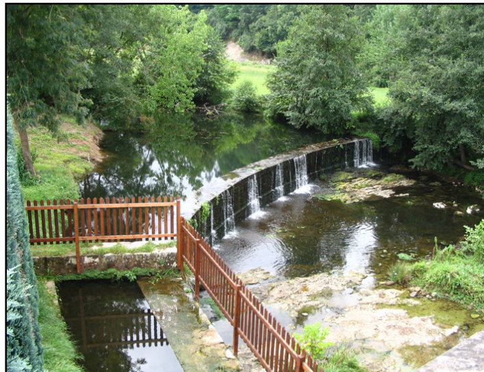
Figura 14. Azud y canal de derivación en el punto de toma de Las Cuevas (Roiz).
