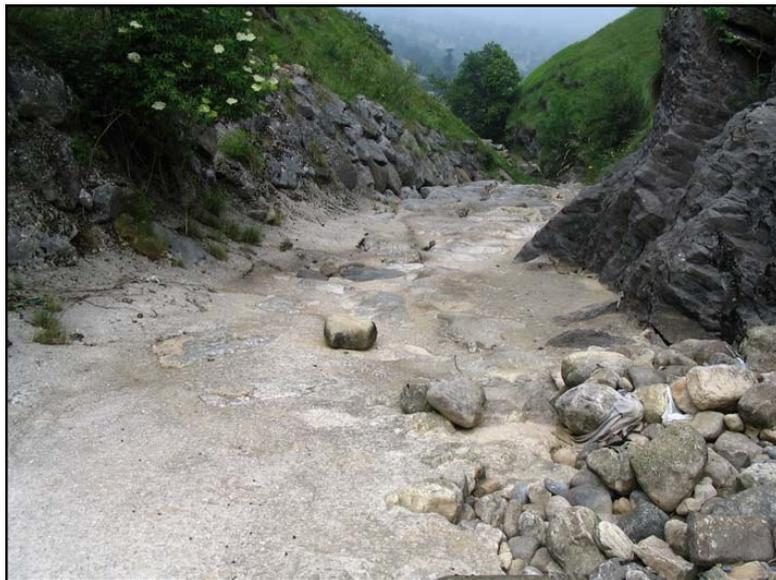
**Figura 16. Fijación del lecho en el tramo alto del Miera.**
