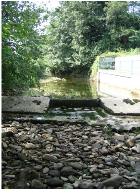
Figura 3. Toma de agua para el abastecimiento de Castro Urdiales, en la que se observa el río seco aguas abajo del azud.
