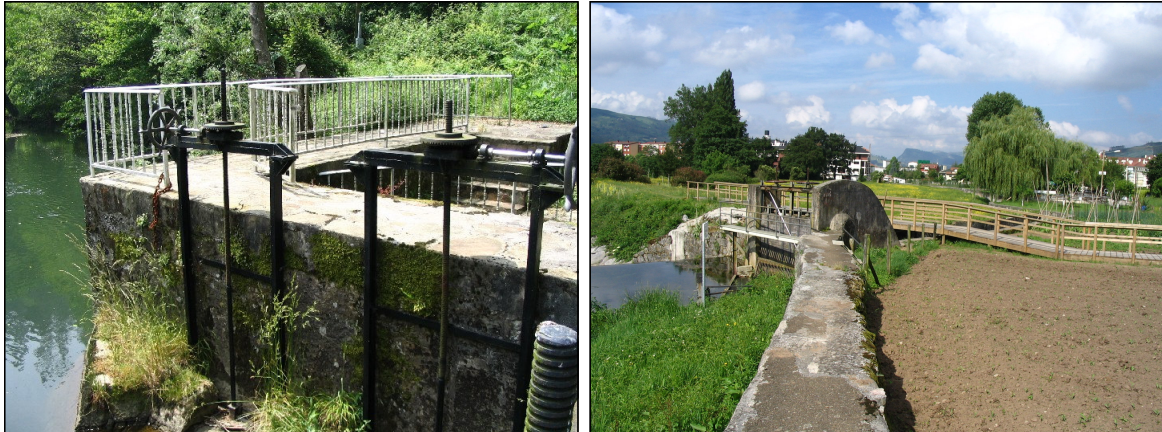
Figura 21. Punto de detracción de caudal en Vega (Villafufre) y el correspondiente a la fábrica de la Nestle (derecha).
