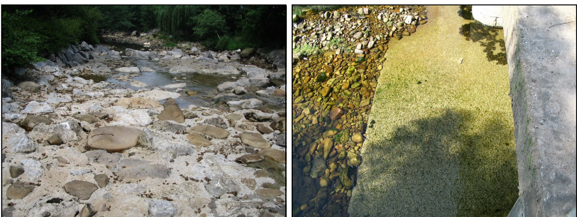
Figura 20. Fijaciones del lecho en el río Pisueña a la altura de Selaya (izquierda) y en las proximidades de Bárcena de Carriedo (derecha).
