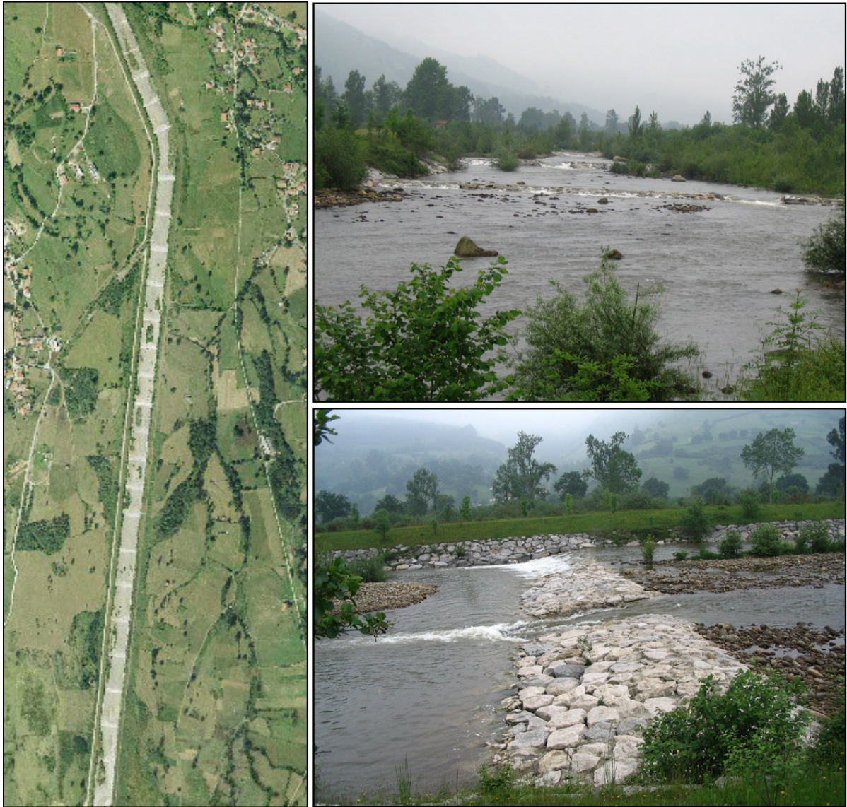
Figura 16. Fotografía aérea de la zona del río Pas canalizada y con traviesas y vistas de detalle del tramo.
